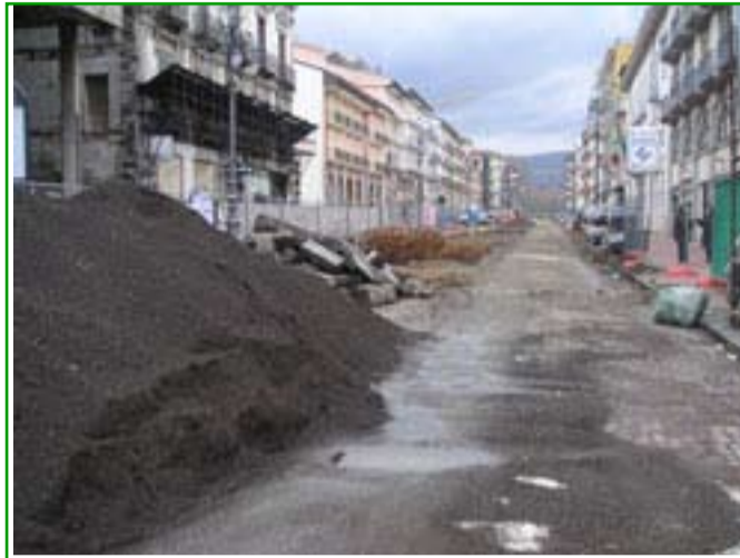
Lavori al Corso Vittorio Emanuele II Avellino
